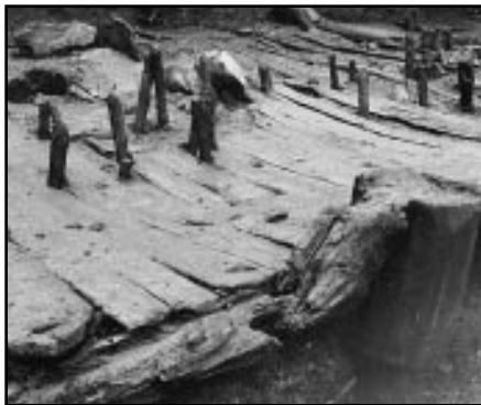
Synlige resultater av komprimering av kulturlag, Søndregt. i Trondheim, 1971.
